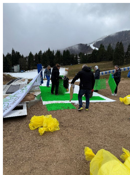
A DESTRA: Stesura del TNT e degli elementi ECOSNOW EVO
